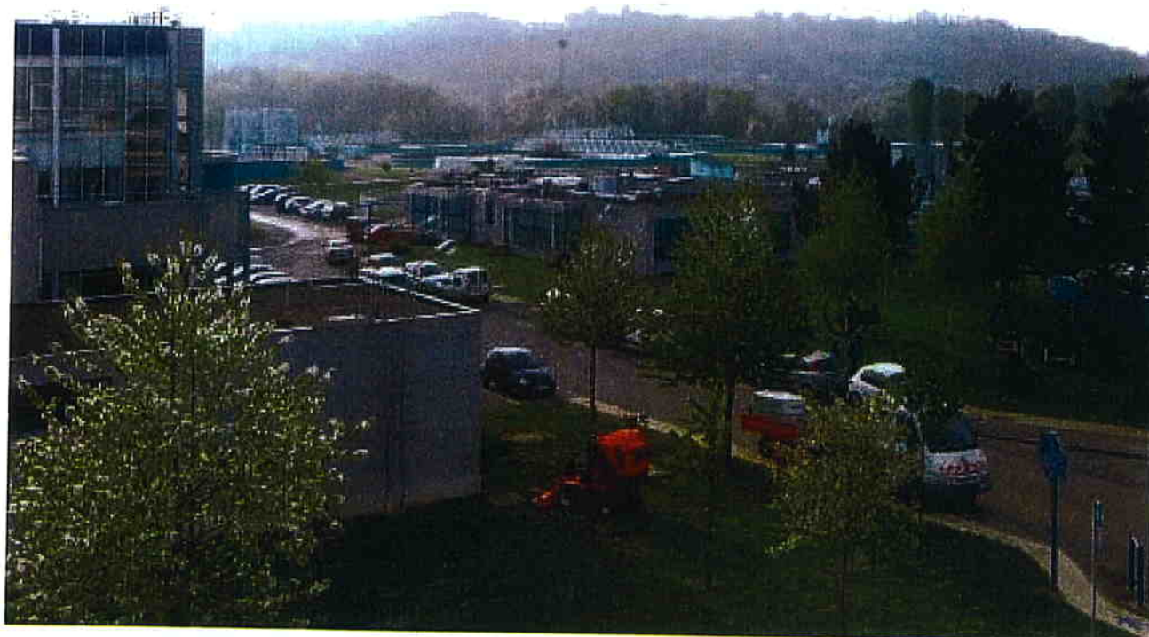
Le centre de traitement principal s'étend sur 12 hectares à proximité du port de Metz. Ci-dessus, de gauche à droite : les bâtiments de la filière de traitement des boues ; le laboratoire d'analyses ; à l'arrière plan, les bassins de traitement biologique sont une partie de la filière de traitement de l'eau.
