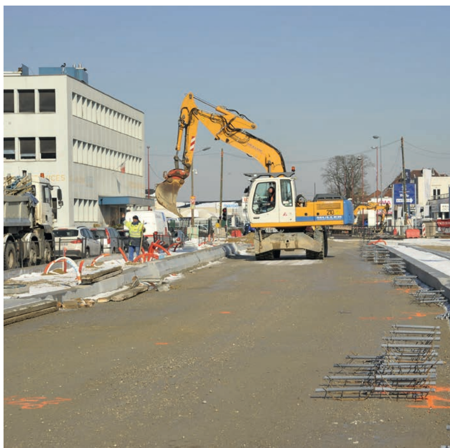
Ci-dessus : route de Thionville, le 15 mars 2013. Réalisation d'un quai de station METTIS.
